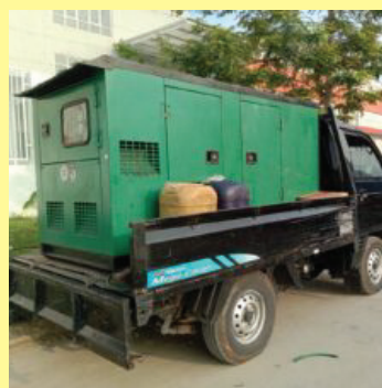
Genset Rp 3.500.000 / unit
